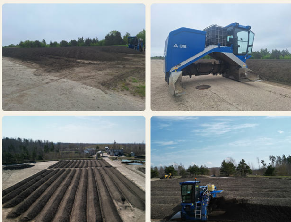
Nuotraukose – „Toksikos“ Klaipėdos grunto valymo aikštelės mastas ir įranga.
